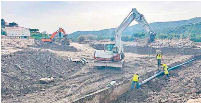
Técnicos de Axaragua reparan la tubería dañada por la tromba de agua.
