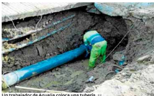
Un trabajador de Aqualia coloca una tubería. EP
