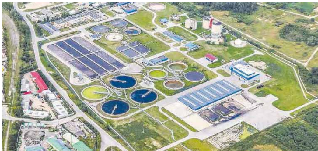
Imagen de una depuradora. | Agencias
