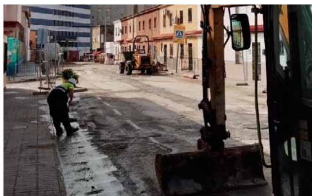
Obras en la barriada de Pescadores de Algeciras. - AI
